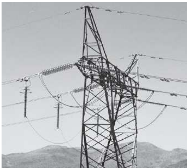
Fig.11 Descărcătoare electrice
