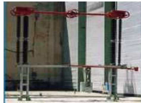
b) separator tripolar rotativ 420 KV
